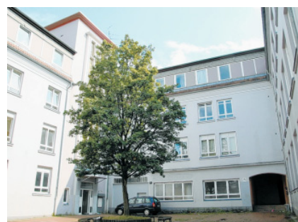
Ein großer Komplex: Die ehemalige Fabrik an der Brackweder Eisenbahnstraße ist 1983 zu einem Wohngebäude umgebaut worden, in das künftig 183 Flüchtlinge einziehen sollen.
